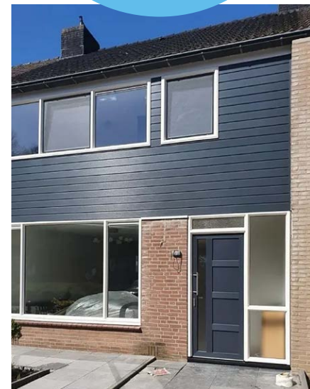
Woning met houten of kunststof panelen
