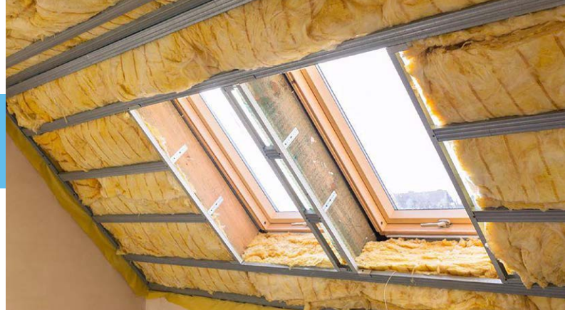
Dakisolatatie binnenzijde
