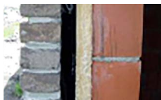
Spouwmuur met gedeeltelijke isolatie
