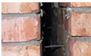
Spouwmuur zonder isolatie
