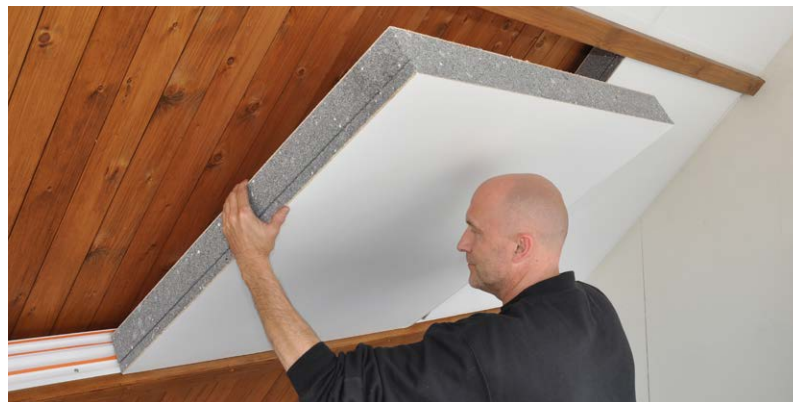
Isolatie aan de binnenzijde tussen de dakbalken
